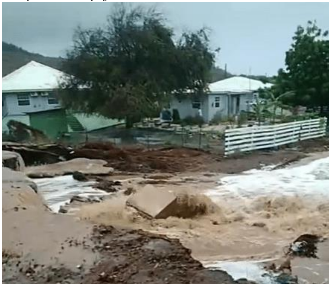
Figuur 2. Schade door hevige regenbui in Banda' Bou in 2024 (+300 mm in 2 uur).
